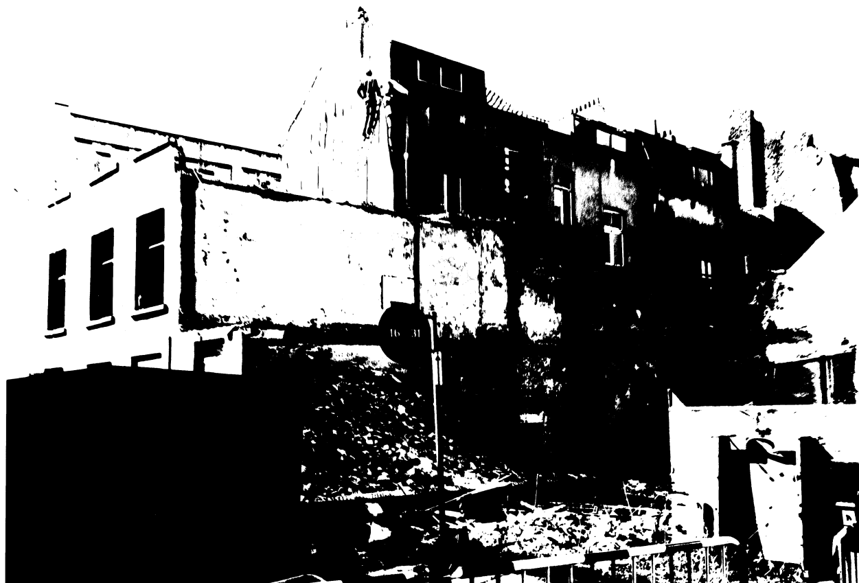
Démolitions au nom de la Salubrité Photo D. Nelissen, Brux.
